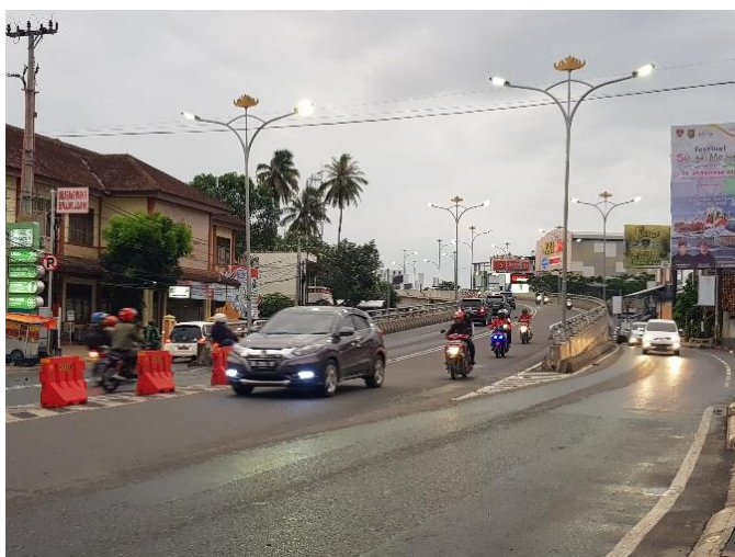
Gambar 1. Kondisi Saat Adanya Pembangunan Flyover Teuku Umar
