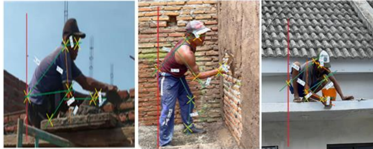
Gambar 1 Pekerja Harian Lepas Melakukan Pemasangan Batu Bata
