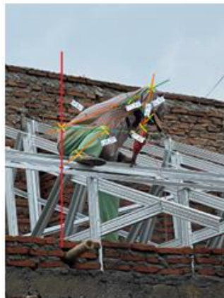
Gambar 2 Pekerja Harian Lepas Melakukan Pemasangan Kuda-Kuda Atap
