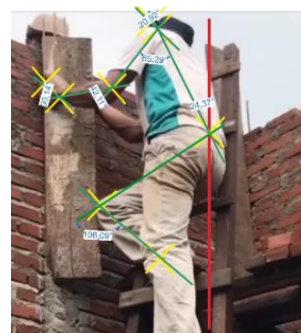
Gambar 4 Pekerja Harian Lepas Melakukan Pemasangan Bekisting Kolom
