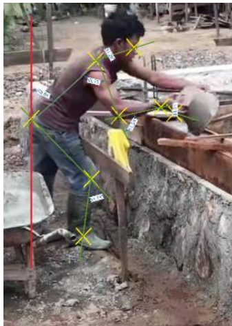
Gambar 6 Pekerja Harian Lepas Melakukan Pengecoran Sloof
