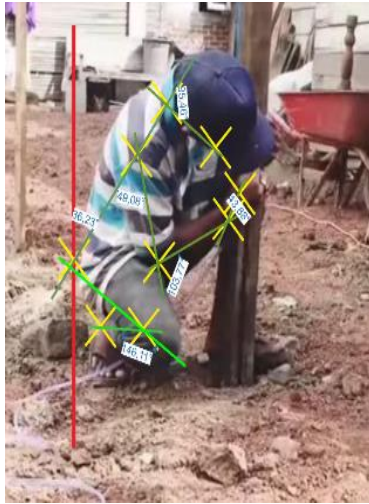
Gambar 5 Pekerja Harian Lepas Melakukan Pemasangan Bouwplank
