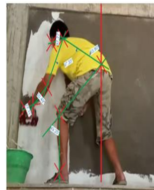
Gambar 3 Pekerja Harian Lepas Melakukan Pengacian
