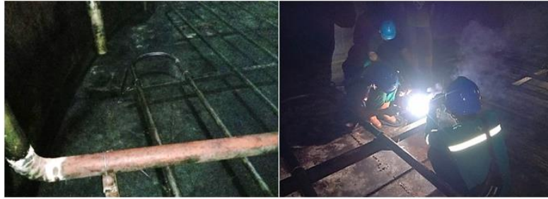
Gambar 7 Pelaksanaan pekerjaan pemanjangan pipa inlet Produksi pada OST.
