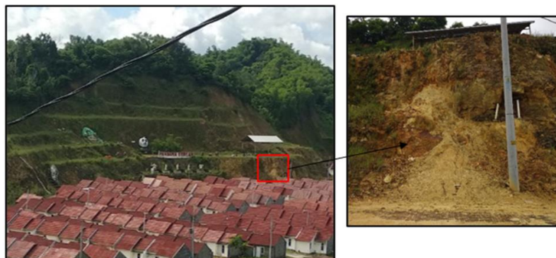
Gambar 3 Kondisi Lereng dengan Gerakan Massa Berupa Rock Fall Setelah Terjadinya Hujan
