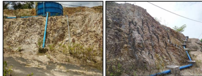
Gambar 5 Kenampakkan Penampungan Air berada di Lereng dengan Bidang Diskontinuitas
