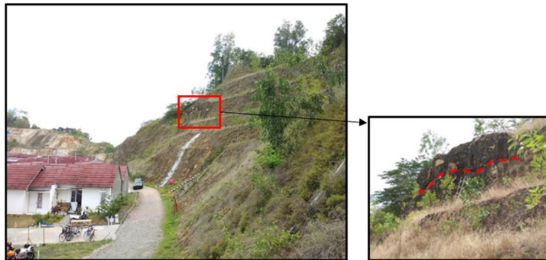
Gambar 2 Peta Penggunaan Lahan dan Gambar Singkapan Batuan dalam Keadaan Lapuk yang Berpotensi Tergelincir
