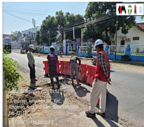
Gambar 1 Test pit pada lubang galian
