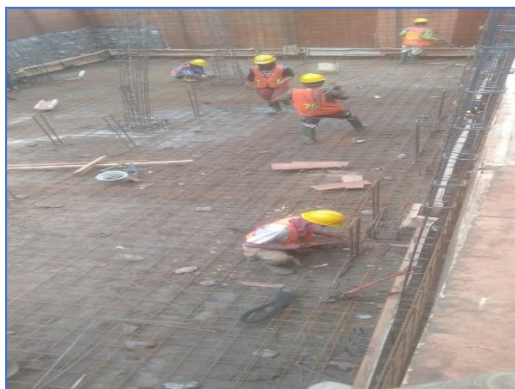
Gambar 9 Pasang Besi dan Bekisting
